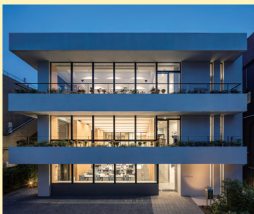
図2 正面からみた新会館
