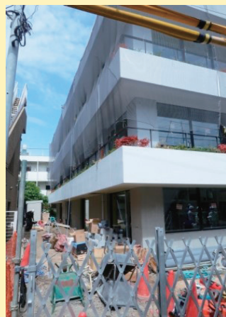
図1 建設途中の様子
