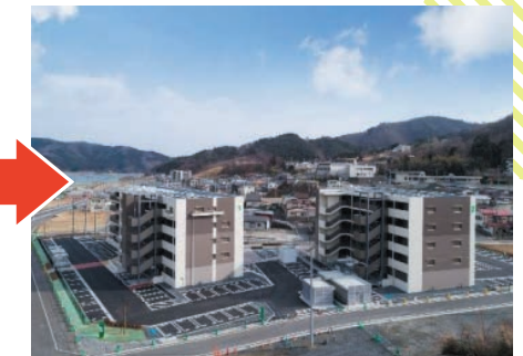
災害公営住宅 宮城県公式ウェブサイト*より
